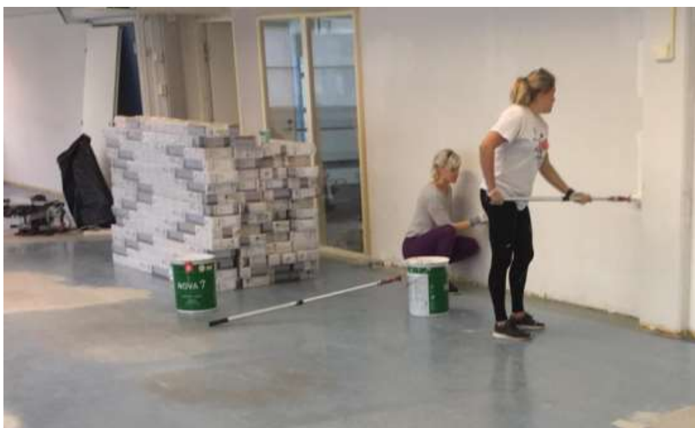
Etusalin seinät saava pintaa ja parketti odottaa asennusta kunnes...
