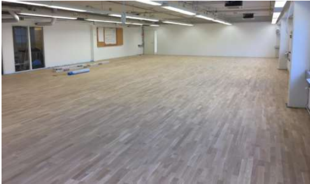
...lattia on saatu asennettua.
