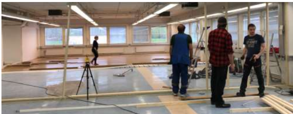
Uudella salilla pystytettiin uutta seinää ja vanhan salin parketti sai uuden kodin.
