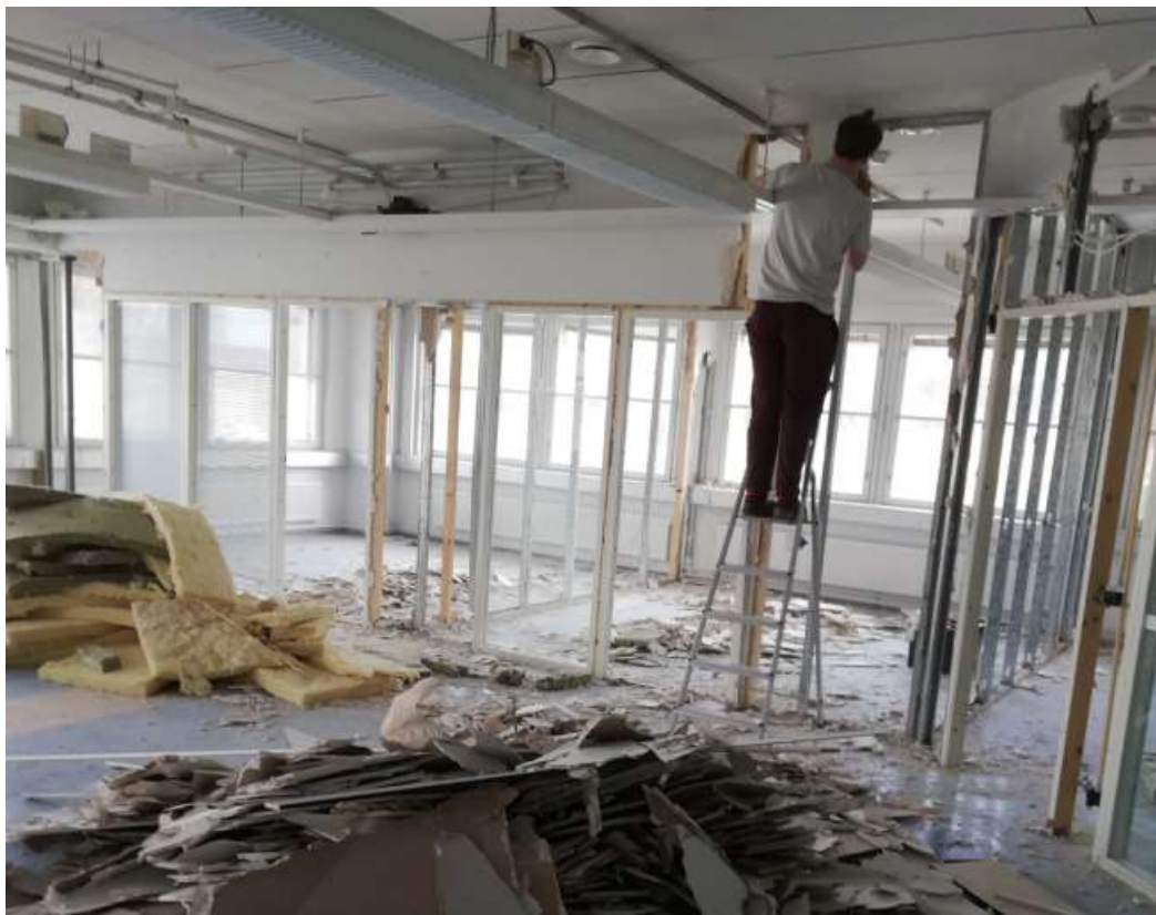
... ja samaan aikaan uuden salin rakenteiden purku oli käynnissä.
